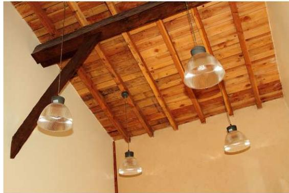
Une grande diversité d'essences a été mobilisée : la charpente et les chevrons sont en douglas ; les murs à ossature bois en épicéa ; les menuiseries intérieures en frêne, l'escalier en hêtre et les brise-soleil en acacia. L'isolation thermique est réalisée avec de la laine de bois et des fibres de bois, fabriquées à l'usine de La Bastide-de-Bousignac (09).
