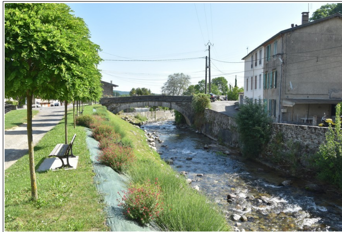
Figure 3.7: le Touyre dans la traversée du village. En arrière plan le pont de la RD509. A l'aval du pont, le Touyre peut déborder massivement en rive gauche.
