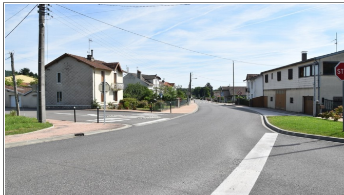
Figure 3.14: RD9 dans le village par laquelle les débordements du ruisseau du Clos peuvent s'évacuer.
