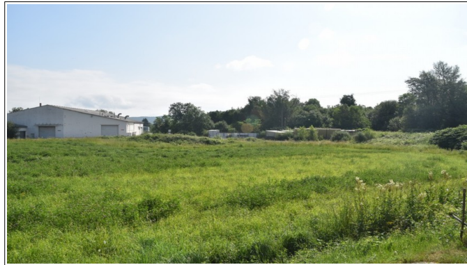
Figure 3.9: usine du lieu-dit la Foulerie ; on distingue au premier plan un chenal préférentiel d'écoulement, ainsi qu'une levée de terre aménagée en travers et le long du champ d'inondation (bordure droite de la photo).
