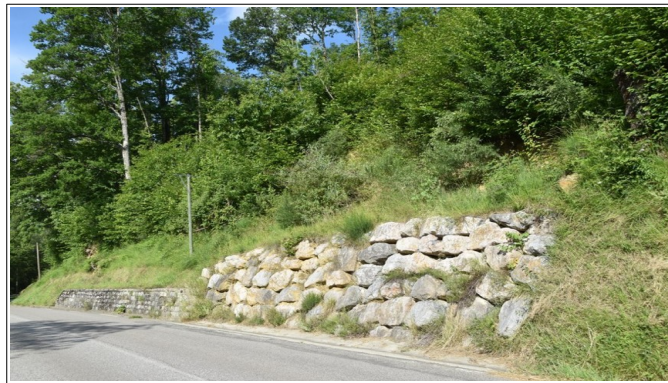
Figure 3.25: ouvrages de soutènement du talus amont de la RD9 en limite communale avec Montferrier.
