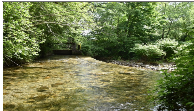
Figure 3.5: seuil et prise d'eau à l'amont du village.
