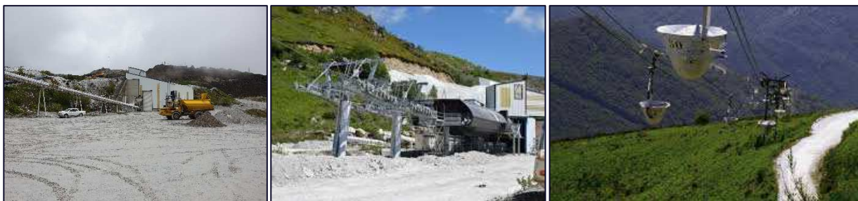
Station de prétraitement et évacuation par téléphérique
