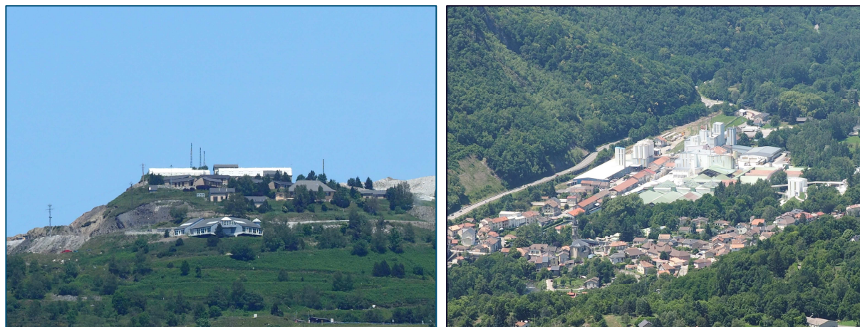
La base vie et les bureaux et l'usine de Luzenac (depuis la route de Lordat) – photos du 26/06/2020
