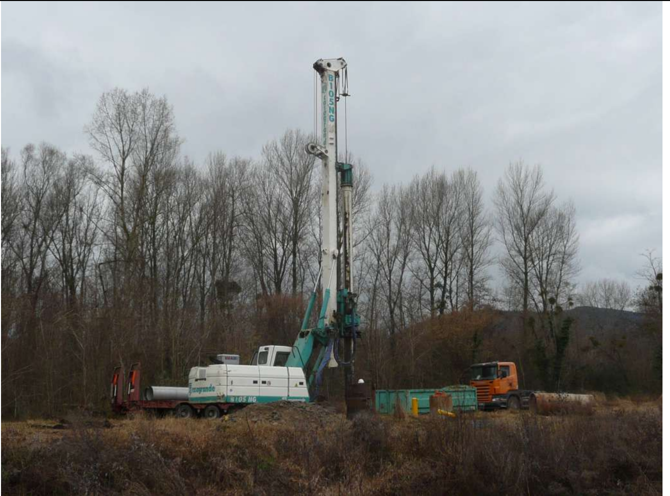
Atelier de sondage, mise en place sur P4
