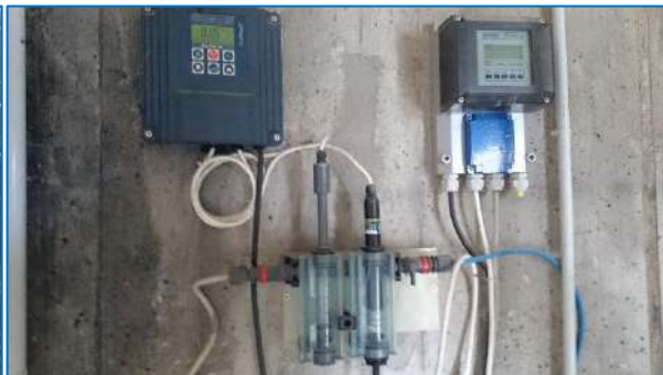
Système de chloration (utilisé ponctuellement)
