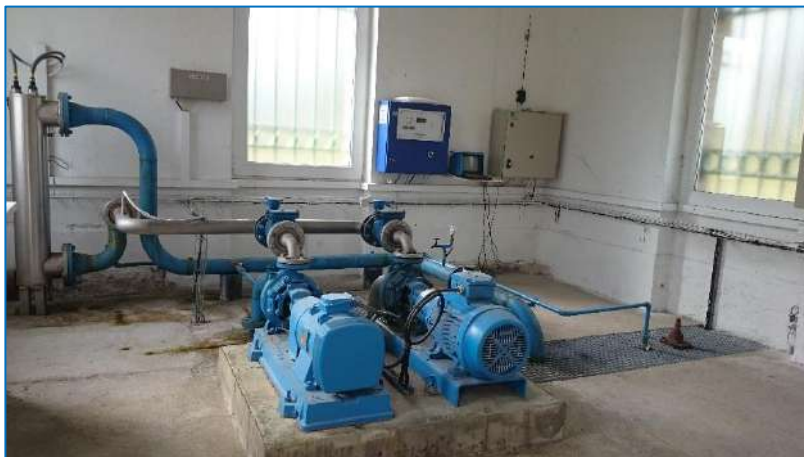
Pompes d'aspiration et traitement UV
