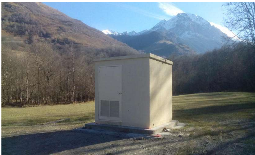
Plateau technique de pompage, aspect final
