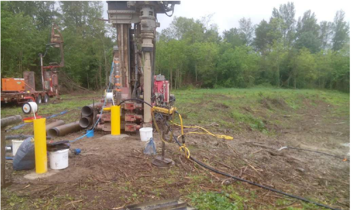
Pompage de développement à P1, P4 en piézomètre, rejet des eaux envoyé à l'Ariège pour le test de longue durée.
