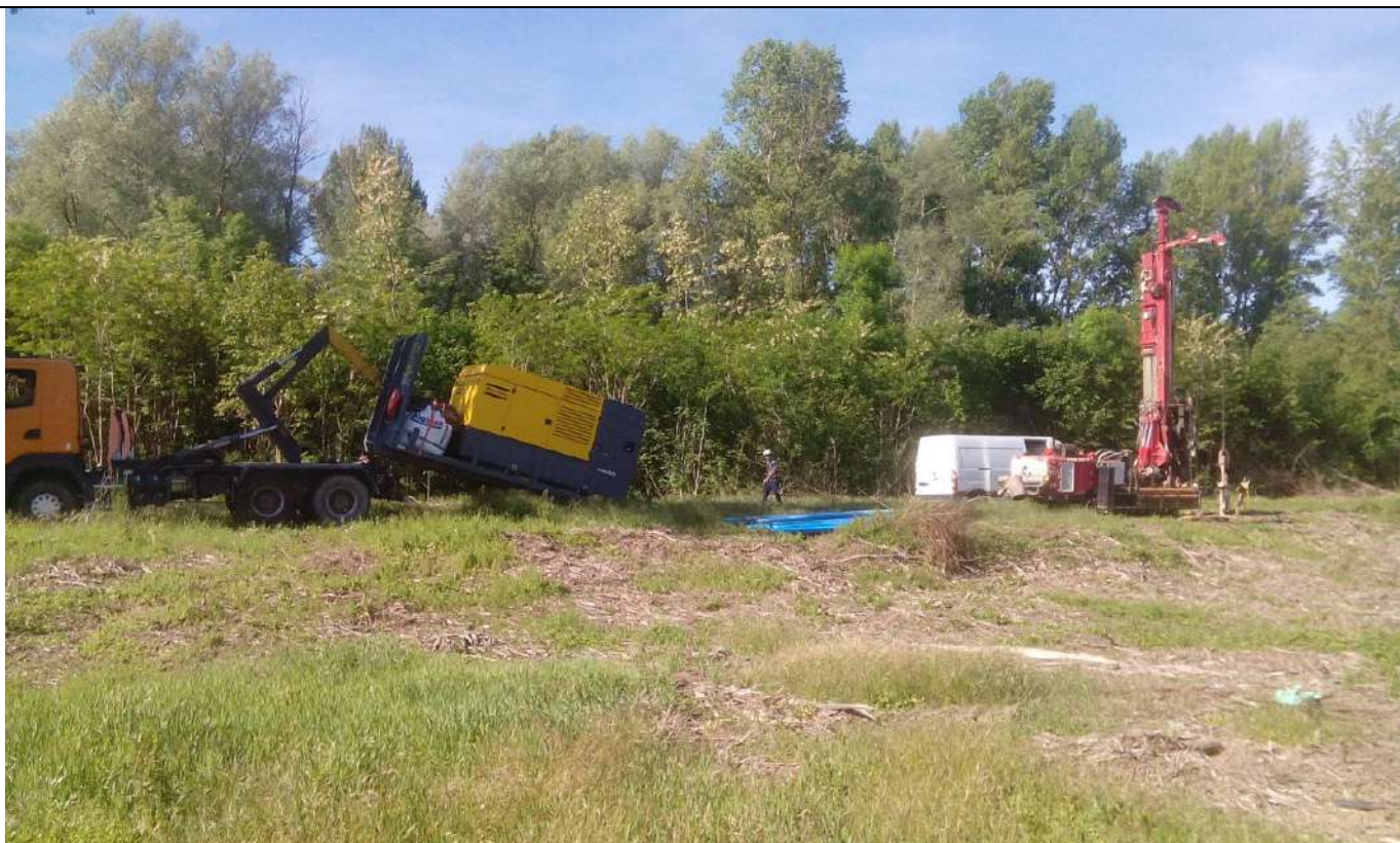
Atelier de sondage, mise en place sur P4
