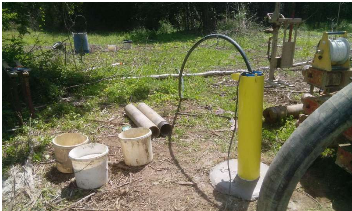
Pompage de développement sur P2
