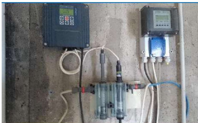
Figure 14 : Photographie du traitement actuel (chloration ponctuelle au réservoir Varilhes)
