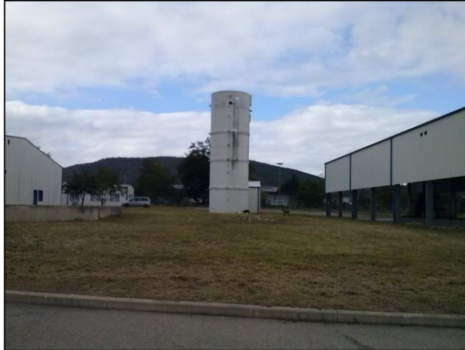
Vue sur la future zone de stockage centrale à bétonner et la réserve incendie (laquelle sera retirée)
