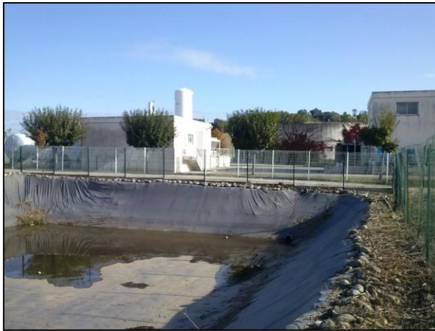
Vue sur le bassin d'orage
